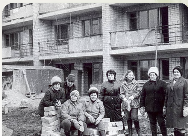
На строительстве санатория «Дубрава»
